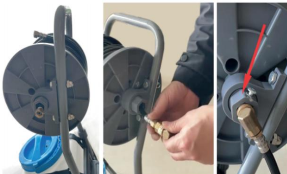
Conectati furtunul principal cu cel scurt si fixate-le cu un surub scurt.
